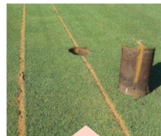
A barázda 15-22,5 cm mélységig kerül feltöltésre homokkal.
